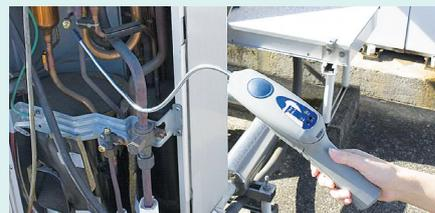
電子式漏えいガス検知器で漏えいを確認
